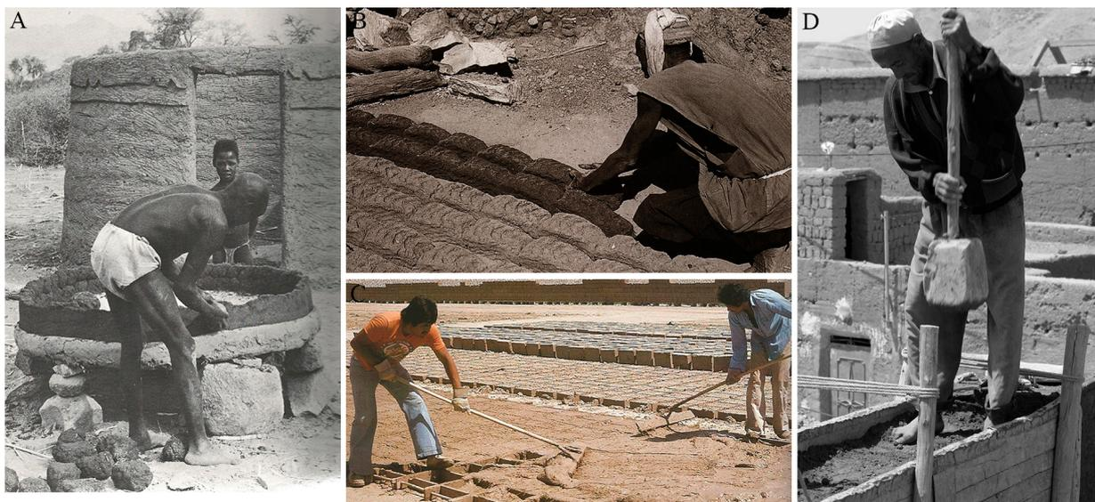
Fig. 1. Diferentes técnicas constructivas con tierra. A. Amasado, aplicado aún húmedo en forma de bolas de barro (Guidoni, 1977, p. 250). B. Adobes fabricados a mano y dispuestos para su secado al aire libre, previamente a ser utilizados (Lauber, 2011, p. 41). C. Producción de adobes con molde (Oliver, 2003, p. 248). D. Tapial (Boussalh *et al.*, 2005, p. 5).
